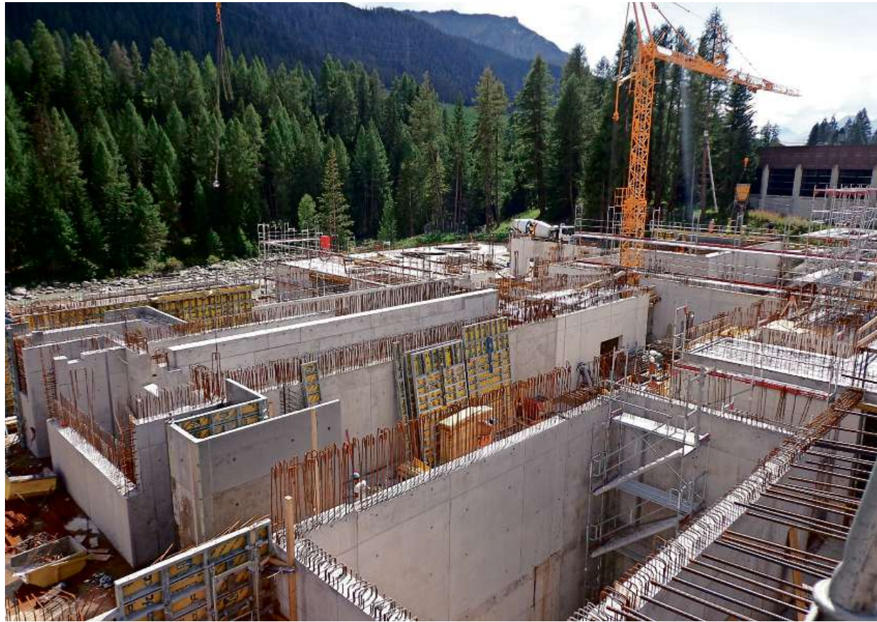
Bald fertig: Der Rohbau der ARA Oberengadin befindet sich in der Endphase.
