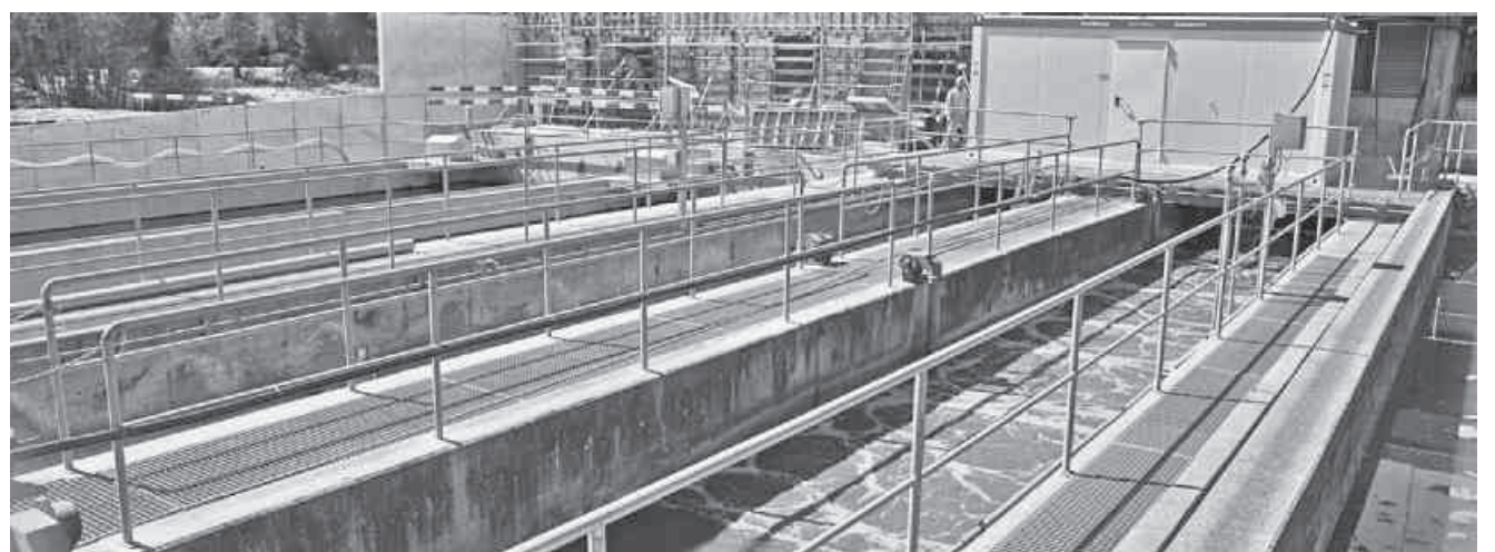
Die Klärbecken, sie werden noch weitere viereinhalb Jahre gebraucht.
