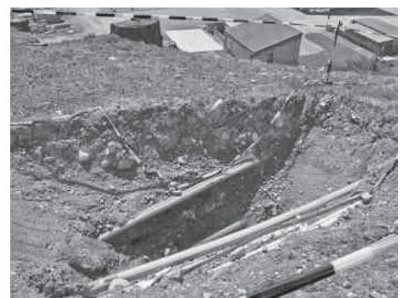
Alte Leitungen müssen erst einmal gefunden werden.
